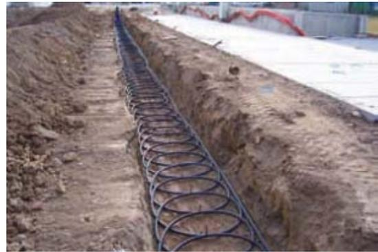
Intercambiador horizontal en bucles de tipología *slinky* horizontal
